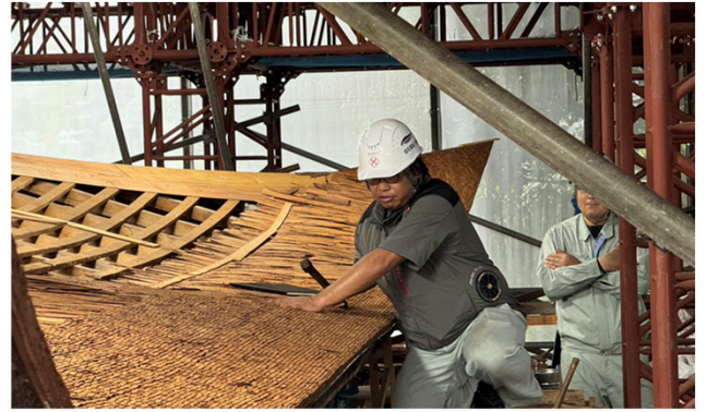
瑠璃光寺 檜皮葺屋根の葺き替え工事
